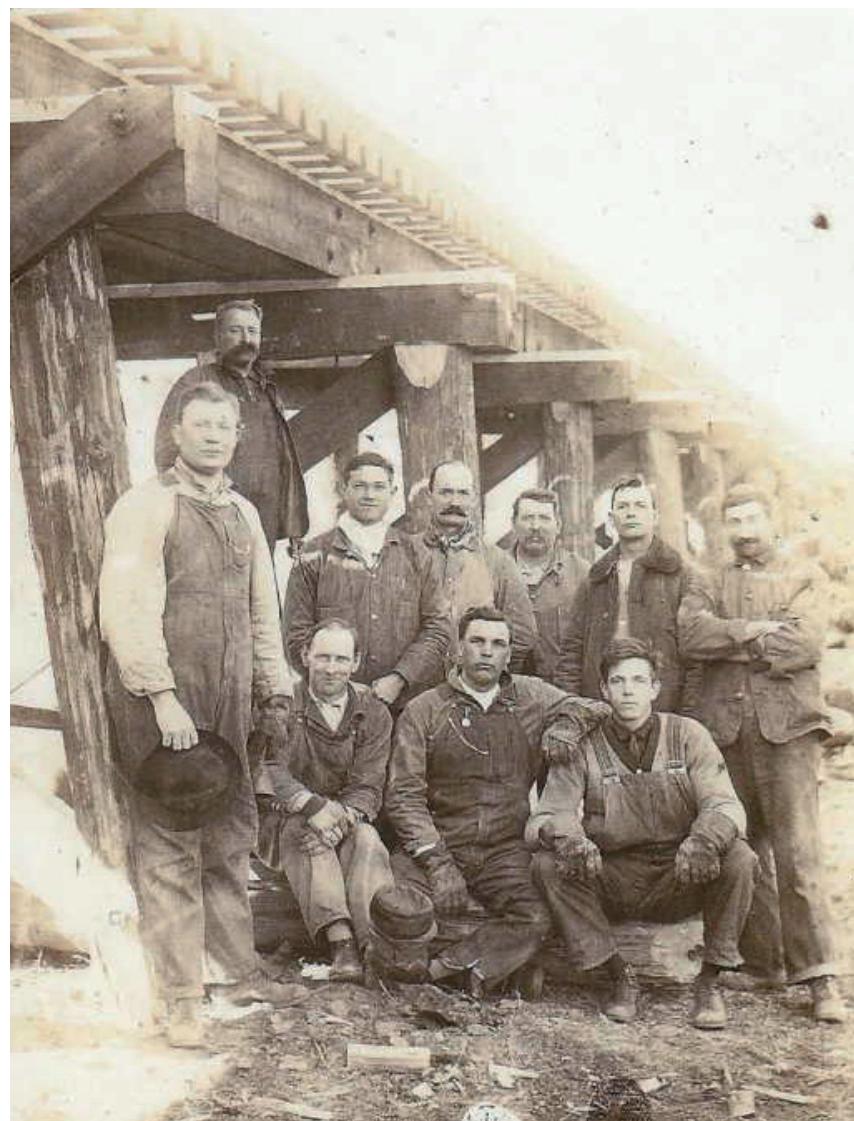
Des charpentiers construisant un pont pour la ligne ferroviaire Saint Louis – San Francisco vers 1903 – Emil Magnin est debout tout à droite.
